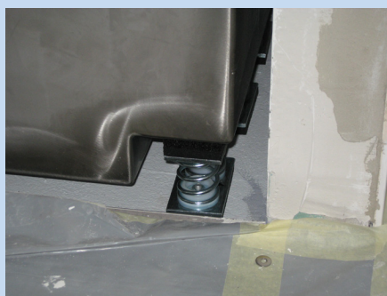
ISOLASTIC-Stahlfederpakete zur Dämmung der tieffrequenten Vibrationen
