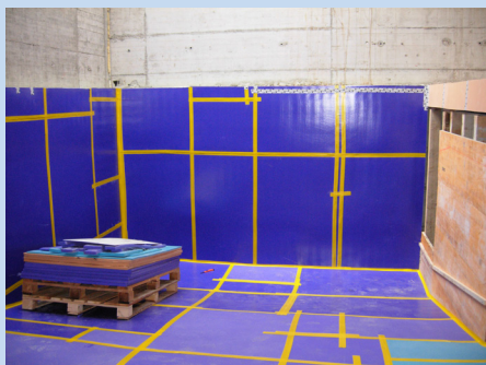
ISOLMER-220 auf Bodenplatte und an den Wänden
