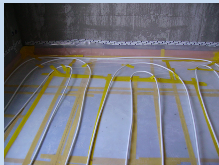
Leicht fixierte Bodenheizung, bereit zum Einbringen des Unterlagbodens
