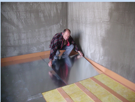
Streifenlagerung mit Stahlblech belegt, Stösse anschliessend verklebt
