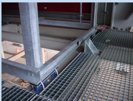
Lagerung der Federelemente ISOFED-N-spezial und Horizontalwinkel des Typs HSW-200-3000
