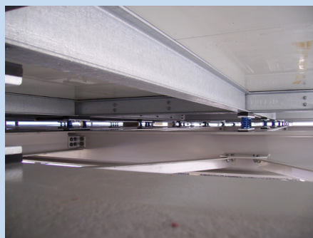
Bei der 64 to schweren Dachzentrale wurden 133 Federpakete eingesetzt
