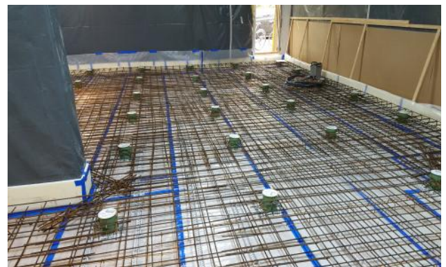
Fertig verlegte Bewehrung. Es gilt jede Körperschallbrücke zu vermeiden – dazu wird die gesamte Lagerung auf eventuelle Fehlstellen kontrolliert und danach zum Betonieren freigegeben.
