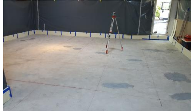
Einmessen der Lage für die Federgehäuse der ISOMATIC-G Federn und Montage der schallweichen Randstellstreifen ISOPE an den Wänden und Stützen.
