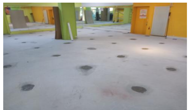
Alle ISOMATIC-G Federn sind eingebaut und gespannt. Der Schwingboden ist bereit für das bauseitige Einbringen des Bodenbelages und die erneute Installation der Fitnessgeräte und Freihanteln.
