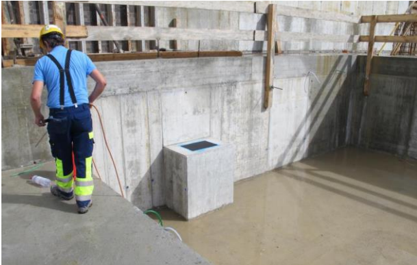
Erstelltes Gebäudefundament mit vorbereiteten Betonsockel für das Versetzen der Stahlfederelemente.
