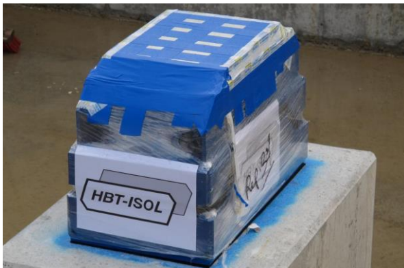
Präzise positioniertes, vorgespanntes Stahlfederelement des Typs ISOFED-G. Eingepackt zum Schutz bis zur Lösung der Vorspannung.
