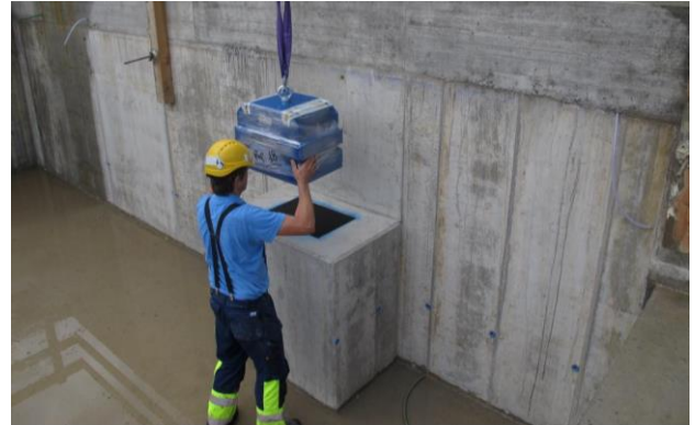
Versetzen der ersten Stahlfederelemente des Typs ISOFED-G. Dieses Element zum restlichen Gebäude / Erdreich verhindert, dass die vom Bahnverkehr verursachten Schwingungen und Erschütterungen direkt in den Konzertsaal eingeleitet werden.
