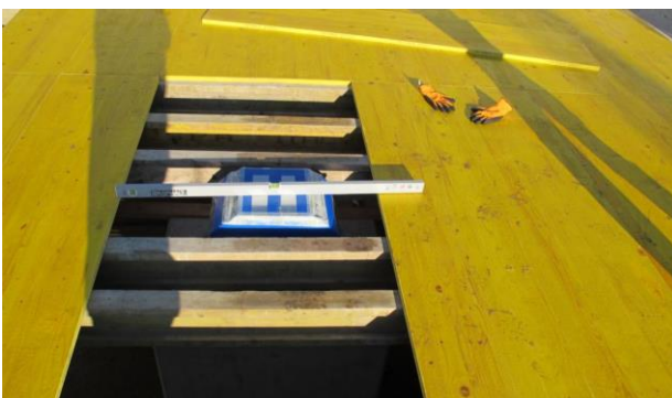
Genaueres Einjustieren der Schalungsplatte zum Stahlfederelement.
